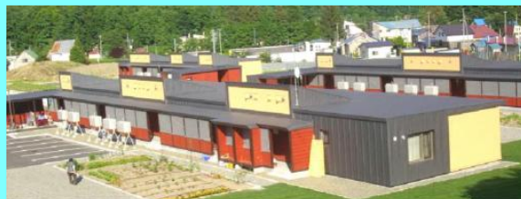
完成したカラマツ市営住宅(夕張市)
